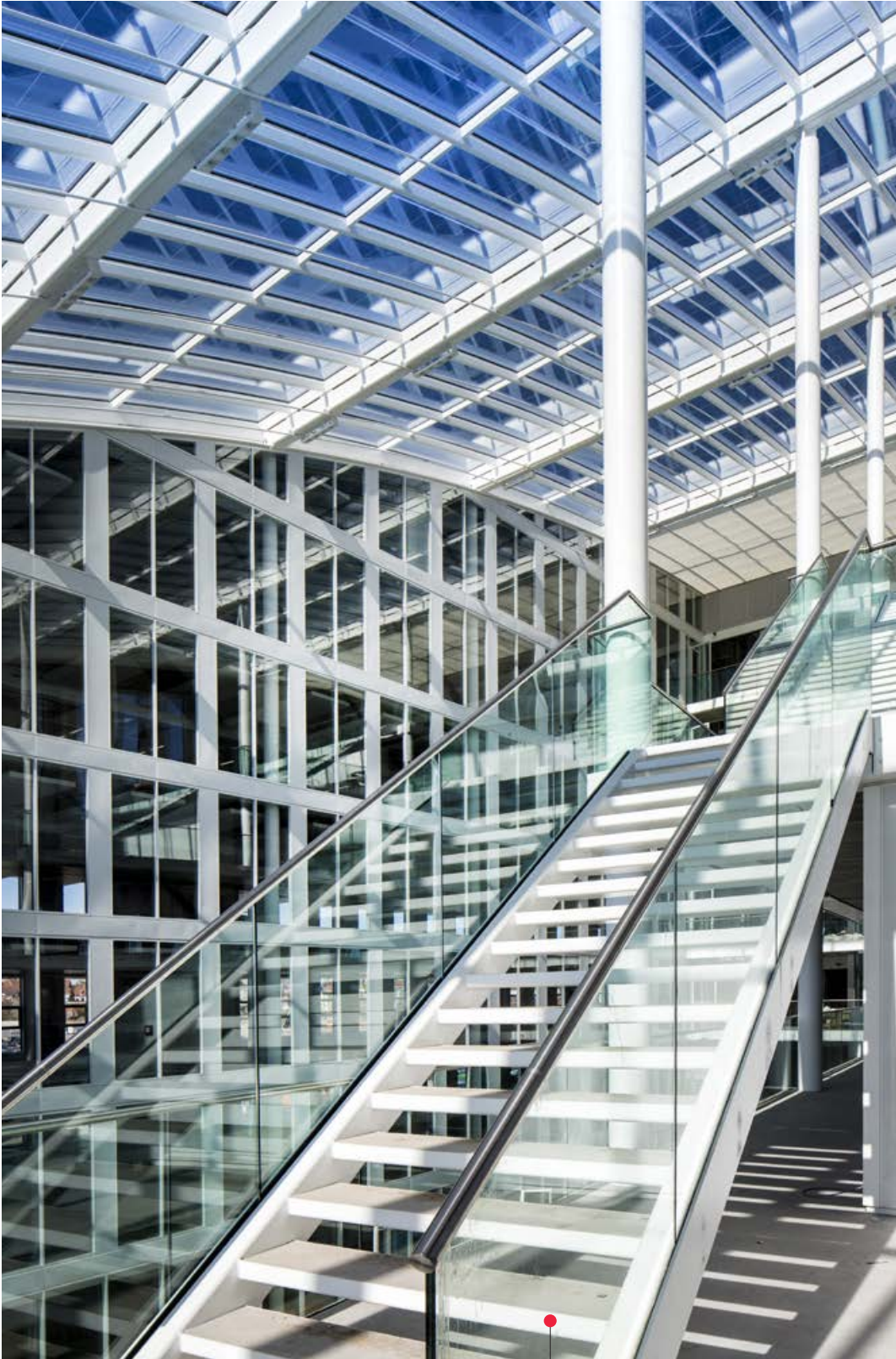
Immeuble de bureaux Port 86C (‘Bruxelles Environnement’) – Bruxelles CBD (BE)
