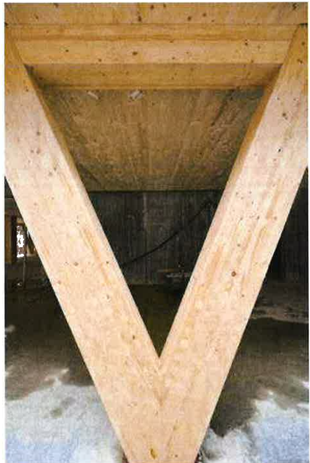
► Détail de la structure en bois innovante de l'immeuble de bureaux Montoyer 10 - Bruxelles CBD (BE)
