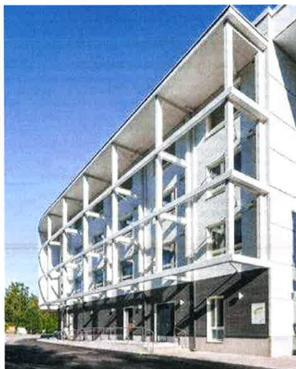
Woonzorgcentrum - Helsinki (FI)
