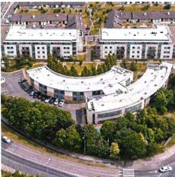
► Luchtfoto van het woonzorgcentrum – Limerick (IE)
