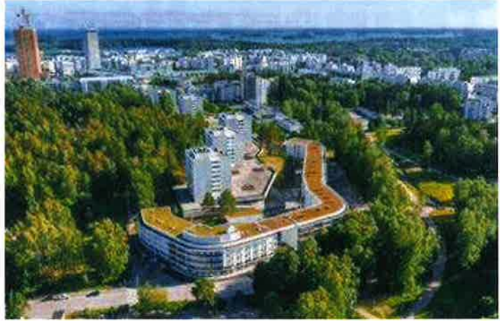
Woonzorgcentrum - Helsinki (FI)
