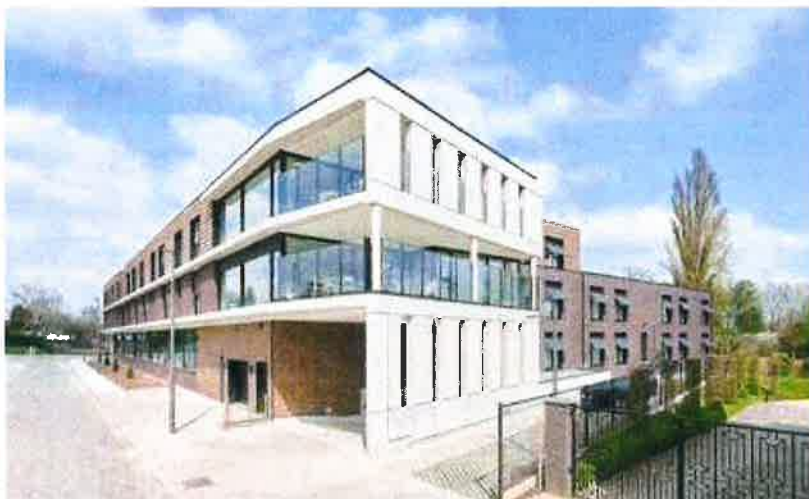
► Woonzorgcentrum Villa Batavia - Grimbergen (BE)
