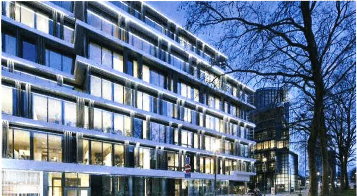
↳ Kantoorgebouw Quartz - Brussel CBD (BE)
