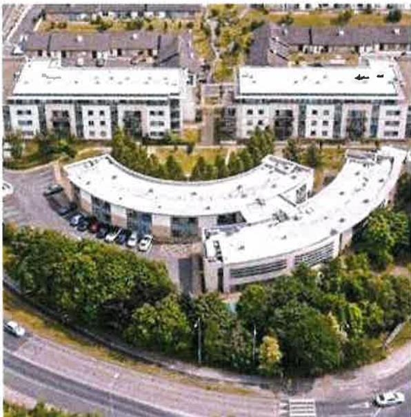
► Luchtfoto van het woonzorgcentrum – Limerick (IE)
