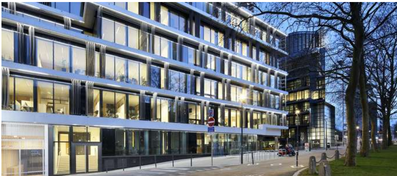
► Kantoorgebouw Quartz – Brussel CBD (BE)
