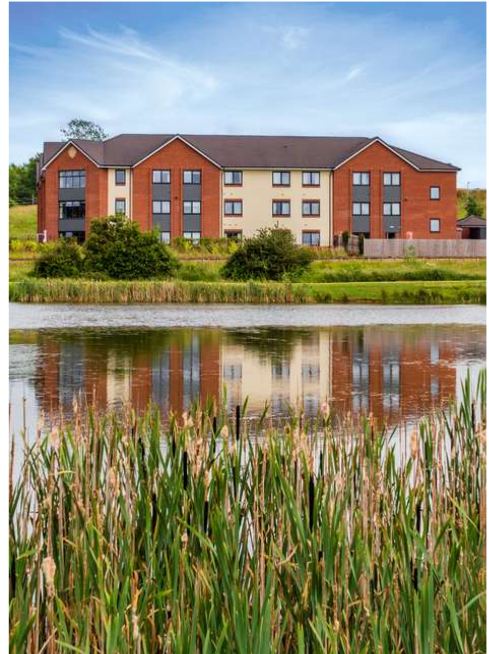
► Maison de repos et de soins – Milton Keynes (UK)
