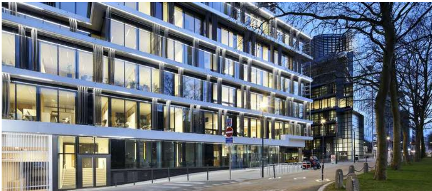
► Kantoorgebouw Quartz – Brussel CBD (BE)
