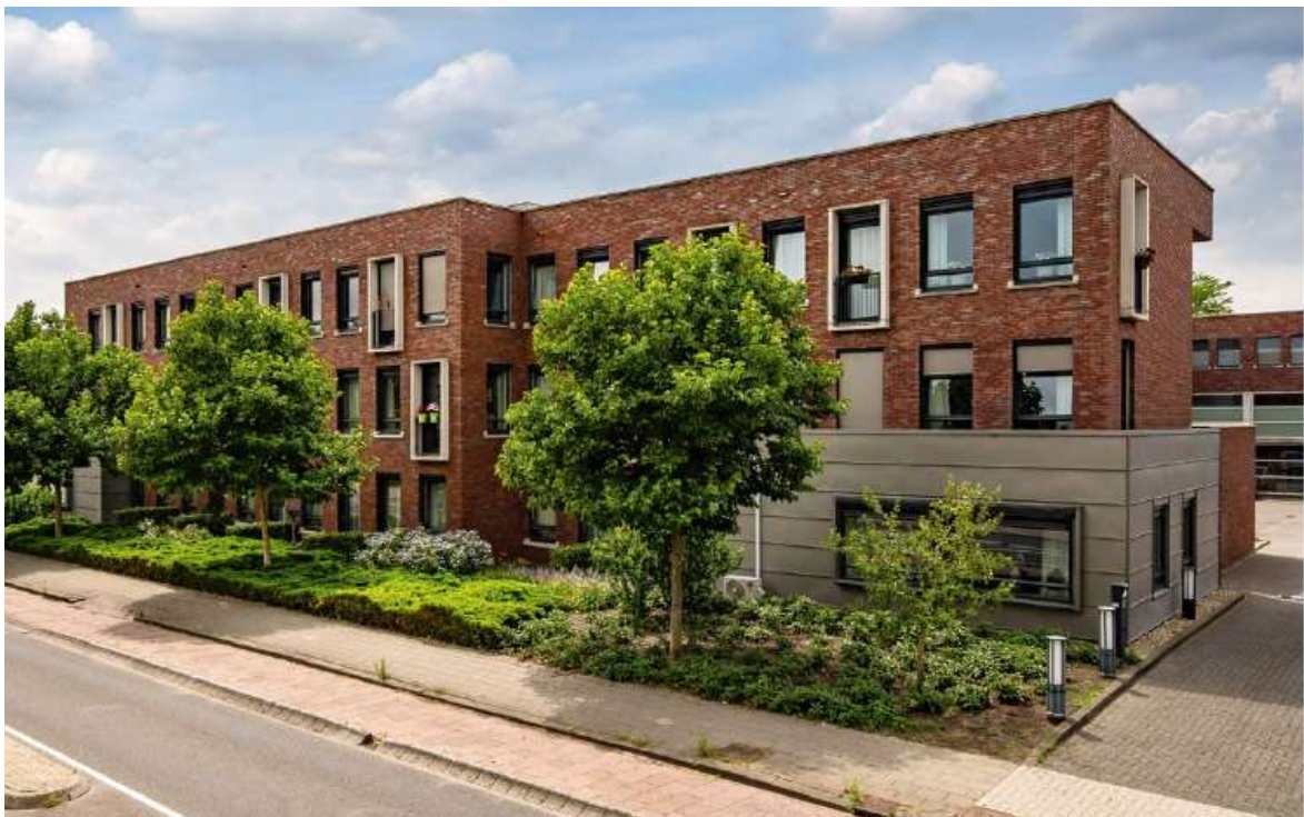
Woonzorgcentrum De Parallel - Nijverdal
